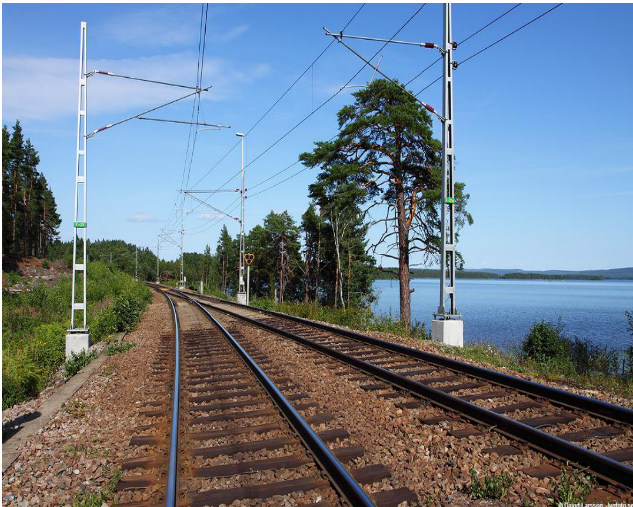
Foto Trafikverket: Hinsnoret mötesstation på Bergslagsbanan mellan Borlänge och Falun. Stationen är 662 m lång och möte med 640 m långa tåg med samtidig infart är inte möjlig. Om det ska vara möjligt måste, av signaltekniska skäl, stationen förångas drygt 400 m.
